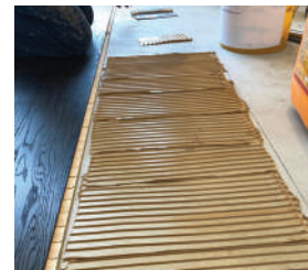
SikaBond®-152: приклеювання паркетної дошки на самовирівнюючу підлогу
