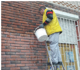
SikaGard-71 W Pro: гідрофобна обробка стіни
