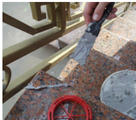
SikaDur-31: ремонт відколеного краєчка сідця гранітних сходів
