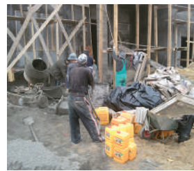
Sika-1, SikaLatex: створення стяжки на плоскій експлуатованій покрівлі
