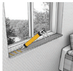
Приклеювання внутрішніх підвіконь
