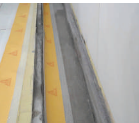
SikaLastic-152 і Sika®SealTape-S: гідроізоляція переливного лотка
