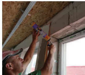
SikaBoom® GP: заповнення швів при монтажі віконних рам
