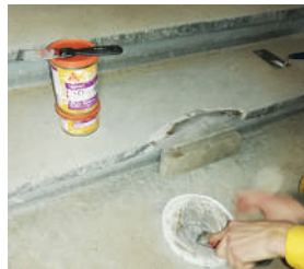
SikaDur-31: ремонт сходів
