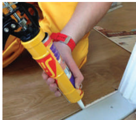
Sikaflex®-11FC+: герметизація шва між порогом та ламінатом
