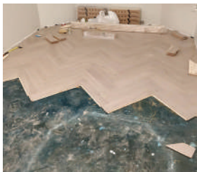
SikaBond®-54 Parquet: приклеювання паркетної дошки на основу, яка була зміцнена з Sika®Primer MB
