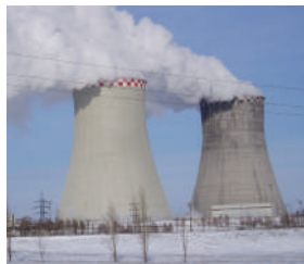
Ремонт і захист залізобетонних конструкцій градирень Зуївської ТЕС, м. Зугрес
