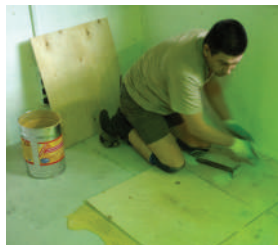
SikaBond® -1000 S: приклеювання фанери на стяжку
