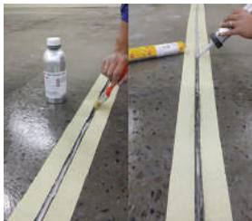
Sikaflex Pro-3 і SikaPrimer-3N: герметизація швів у підлозі
