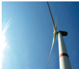
Гідроізоляція фундаментів вітрових енергетичних установок, м. Новоазовськ, «Вітряні парки України»
