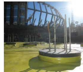
Гідроізоляція підземної частини НСК Олімпійський, м. Київ
