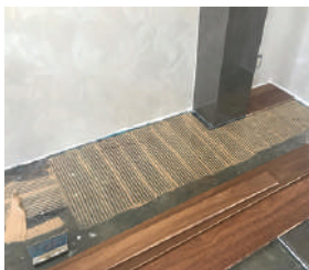
SikaBond®-152: приклеювання паркетної дошки на самовирівнюючу підлогу
