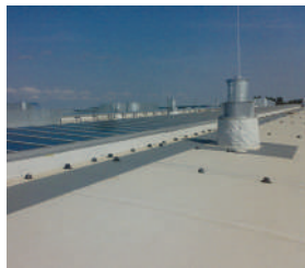
Покрівля терміналу F, аеропорт Бориспіль
