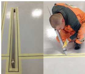
Sikaflex Pro-3: герметизація швів у підлогах виробничих приміщень
