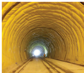
Гідроізоляція Бесидьського тунелю
