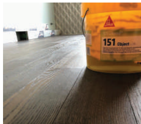
SikaBond®-151: приклеювання паркетної дошки на самовирівнюючу підлогу
