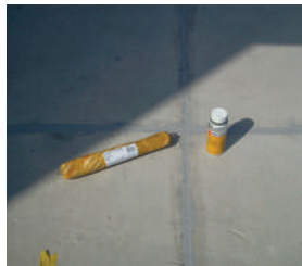
Sikaflex® PRO-3: температурно-усадочні шви на терасі
