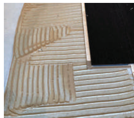
SikaBond®-151: приклеювання паркетної дошки на самовирівнюючу підлогу
