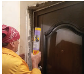
SikaBoom® GP: встановлення дверей
