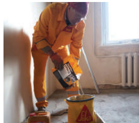
SikaPlast-520, SikaFiber PPM-12: влаштування стяжки
