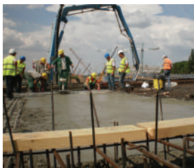
Добавки в бетон при будівництві шляхопроводу перед терміналом D, Україна, аеропорт Бориспіль
