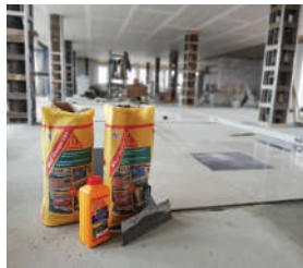
SikaCeram-101, SikaPrimer-01: приклеювання плитки на підлогу
