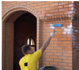
SikaGard-S: очистка висолів на цегляній стіні
