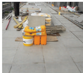
SikaLastic-152: гідроізоляція тераси
