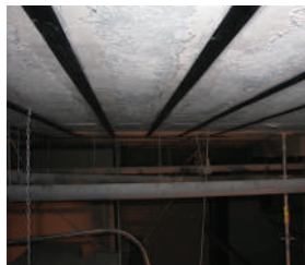
Підсилення залізобетонних конструкцій вуглепластиковим стрічками Sika®Carbodur®, м. Маріуполь
