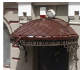
Sikaflex®-11FC +: шви між стіною і козирком
