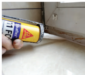
Sikaflex®-11FC+: герметизація швів віконної рами
