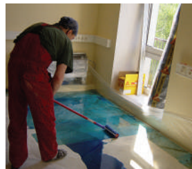
Sika®Primer MB: зміцнення стяжки і контроль вологості
