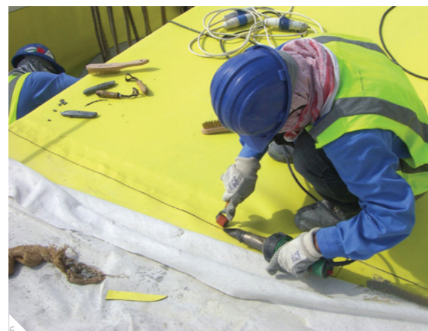
Системи рулонних мембран, які розділяються на секції для контролю та ін'єктування
