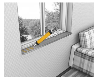
Приклеювання внутрішніх підвіконь.
