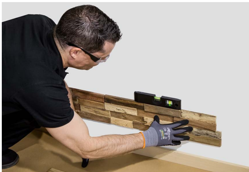
Приклеювання деревини всередині приміщення.
