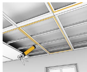
Приклеювання гіпсокартонних плит до дерев'яного каркасу.
