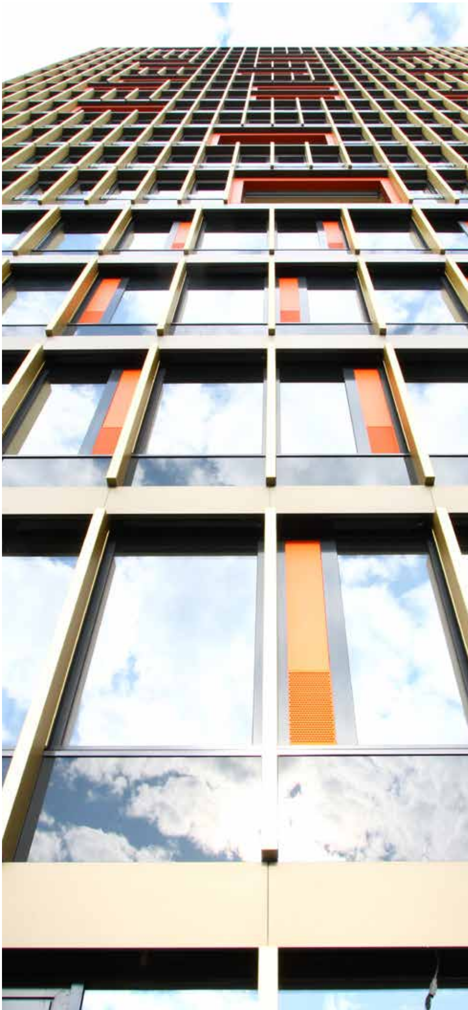
Зліва Leutschentower, Цюрих, Швейцарія, 2011 Архітектор: Bétrix Consolascio; Architekten AG, Zurich Виробник вікон: Baumgartner AG Тип вікна: дерево / алюміній із віконними ступками, що відкриваються, які склеєні матеріалом SikaFast®-5201 NT
